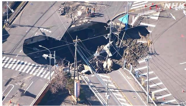
八潮市で発生した道路陥没事故
